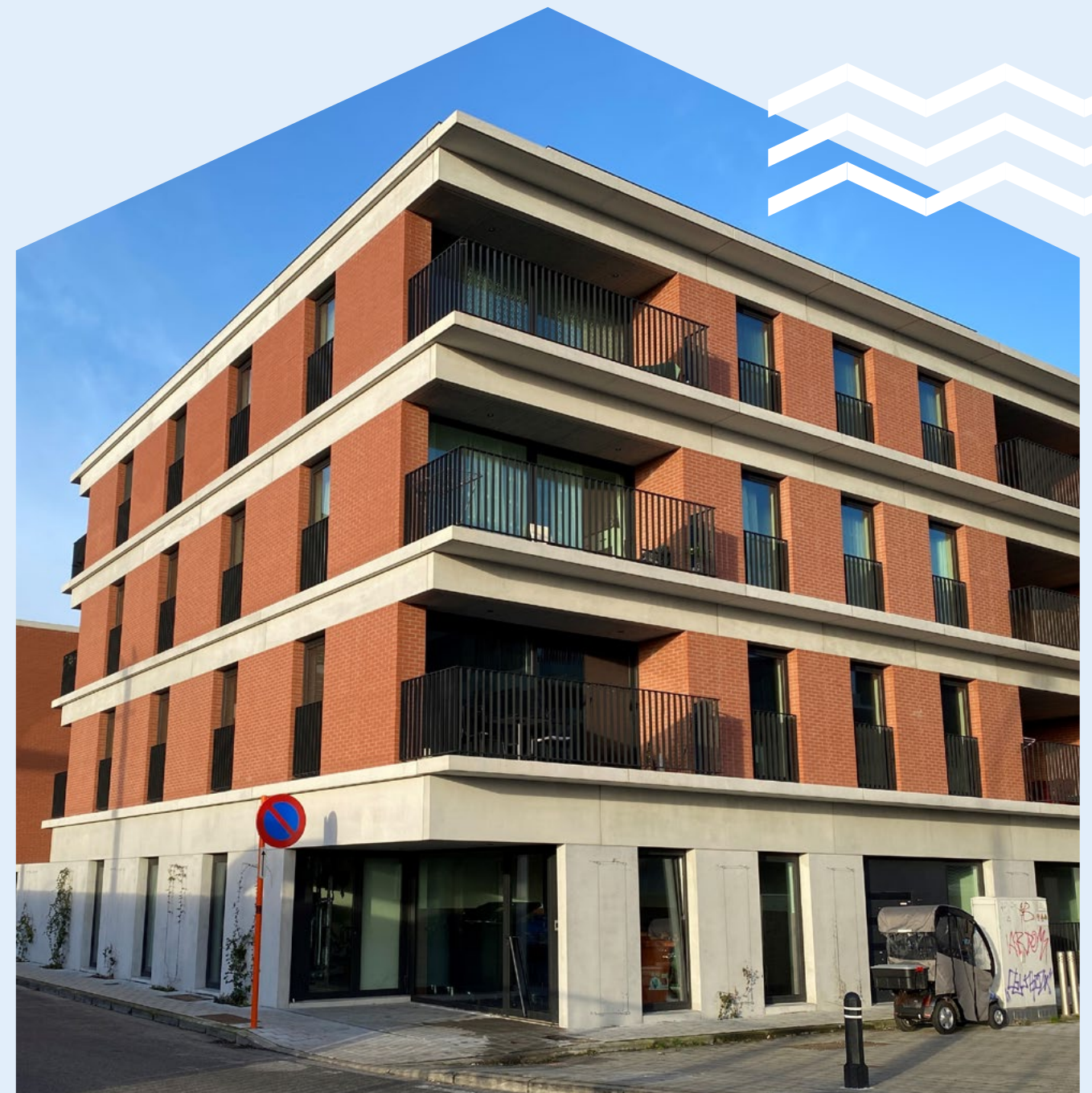
Nieuwe sociale woningen in de Kraankinderstraat en Klipperstraat.
